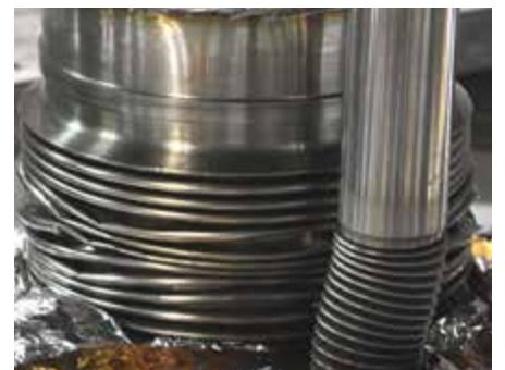
震災で亀裂が生じ、真空破壊を起こしたベロー
