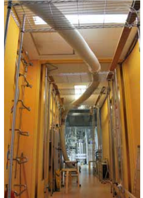
ヘリウム容器の通路を確保するため、簡易断熱配管をスチールラック上に配管
