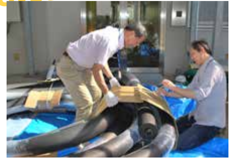
簡易断熱配管の開発をしている作業風景
