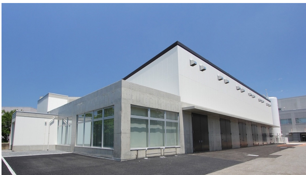
図：水素防爆の仕様を備えた水素環境材料実験棟。液化水素を含む低温水素環境での材料の機械的特性を評価する試験設備 4 台とともに、内容量が 24,000L の液化水素貯槽を設置。
