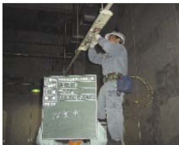
照明器具省エネ型へ改造(安定器交換)
