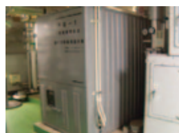
直焚き蒸気吸収式冷温水機（千現）
