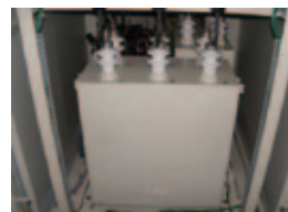
変電設備（千現） 力率改善用進相コンデンサー（千現）
