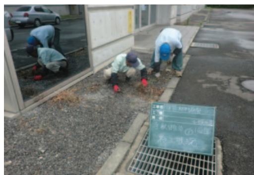
砂利地除草作業(千現)
