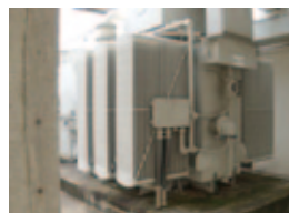
変電設備（千現） 力率改善用進相コンデンサー（千現）
