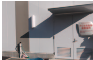
PCB廃棄物の保管庫 (並木)
