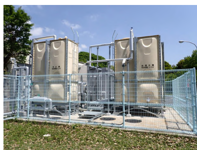
地下水処理装置 (千現)
