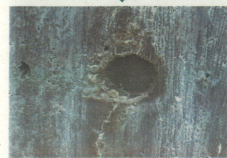
修復後（写真提供：會澤高圧コンクリート株式会社）
