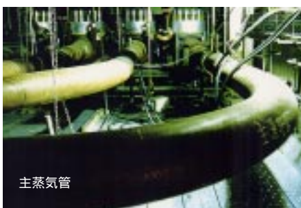
図1 厚肉で直径が大きい大型部材の主蒸気管や管寄せなど。発電プラントの主要な構造物（写真：三菱重工業）
