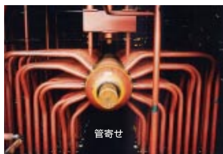
図1 厚肉で直径が大きい大型部材の主蒸気管や管寄せなど。発電プラントの主要な構造物（写真：三菱重工業）
