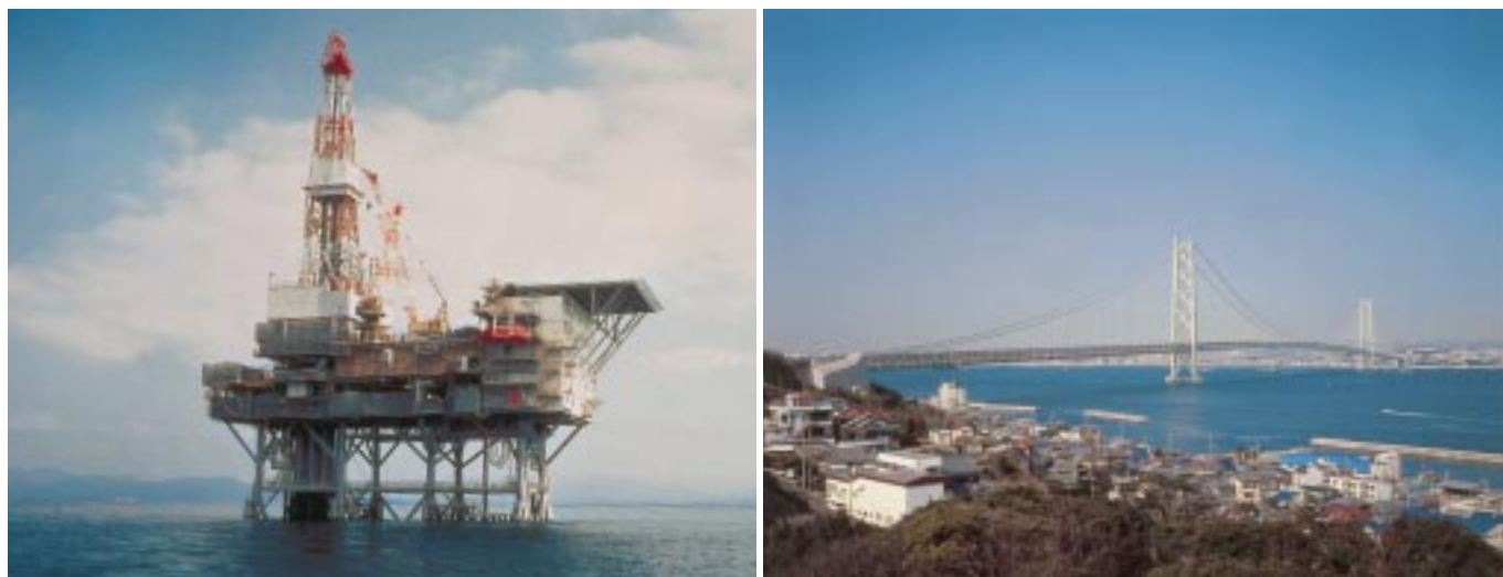
図1 石油掘削リグなどの海洋構造物である岩船沖プラットフォーム（左）と明石海峡大橋（右）。海上に建てられた海洋構造物は塩化ナトリウムなどの塩の飛沫（ひまつ）による腐食環境の下に置かれており腐食対策が施される（写真は新日本製鐵提供）
