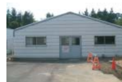
PCB廃棄物の保管庫 (並木)
