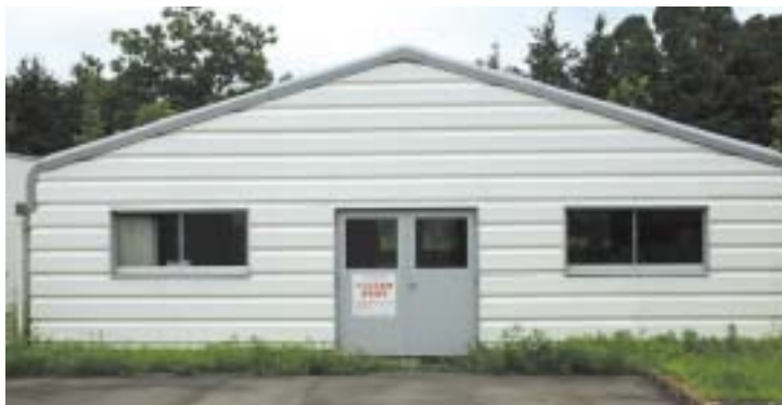
並木地区PCB廃棄物の保管庫
