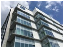
先進構造材料研究棟 (千現)
