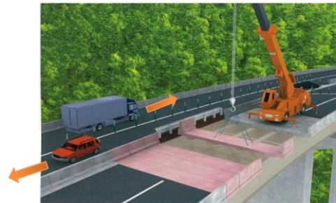
床版取替え工事のイメージ
